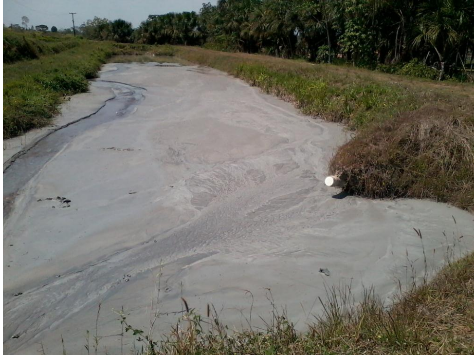
Figura 15- Lagoa de decantação.
