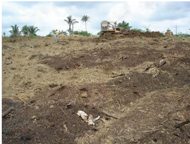
Figura 18- Aterramento para recuperação concluído.
