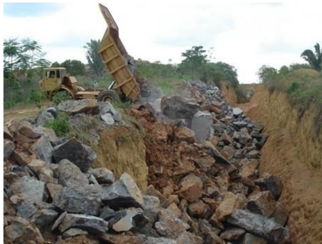
Figura 16- Início da recuperação da jazida. Fase 1.
