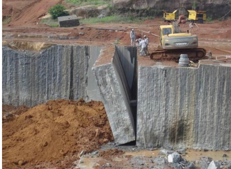
Figura 06- Processo de extração em jazida através do uso de explosivos.
