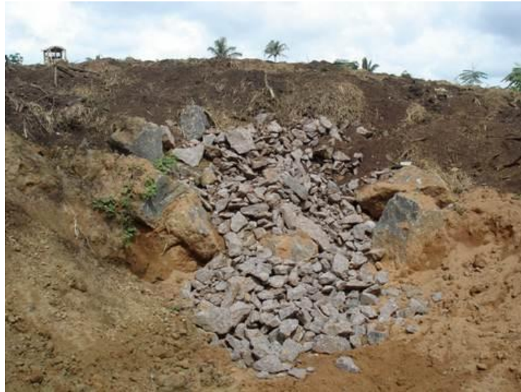
Figura 17- Início da recuperação da jazida. Fase 2.
