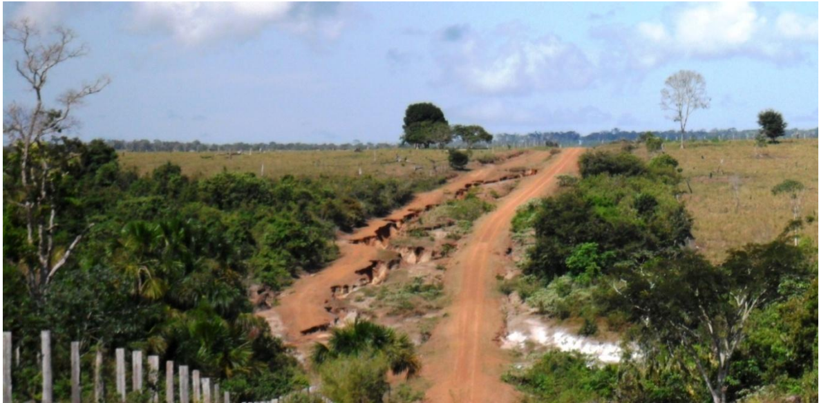
Figura 18 – Realocação de estrada municipal na área em estudo devido à formação de ravina. Fonte: A autora, tomada em 25/06/2013, coordenadas 61° 44' 18" e 12° 23' 25".
