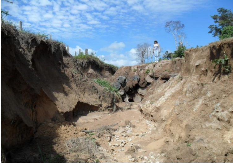
Figura 19 – Medida de contenção do processo erosivo junto à malha viária.
