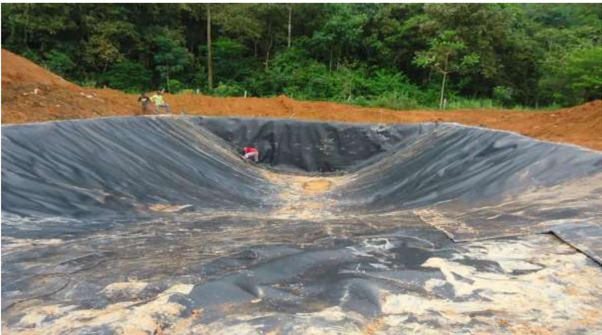
**Figura 11** - Construção da trincheira utilizada para destinação final dos RSS no aterro controlado de Ji-Paraná/RO.
