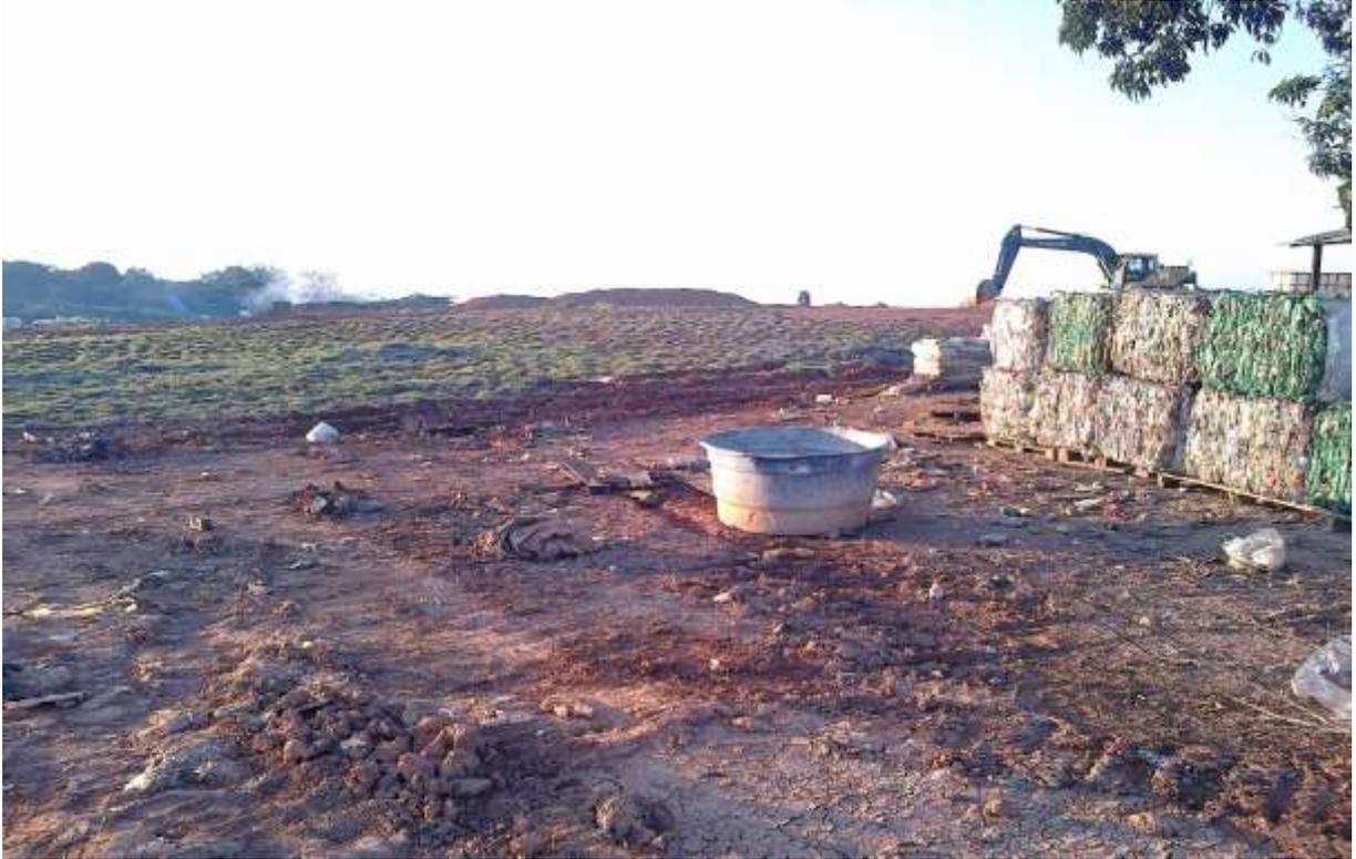
**Figura 15** - Área do aterro já utilizada e com a cobertura final concluída.
